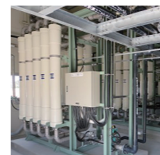
沖縄県糸満市農業用再生水実証施設
